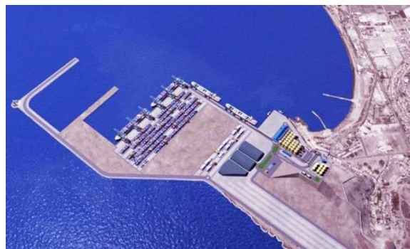
Fotografía N° 01: Vista aérea del actual puerto de Chancay en construcción.
